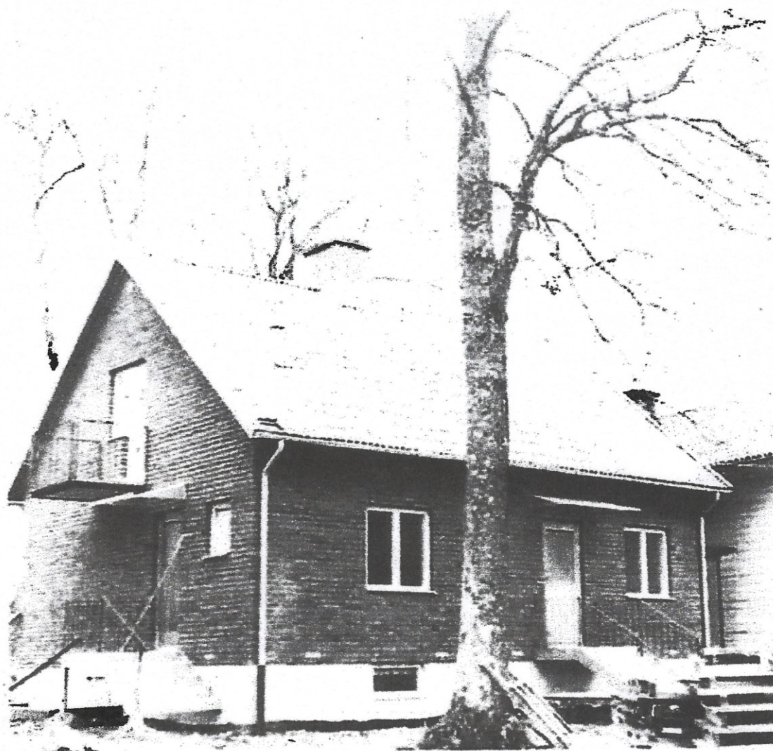
Den nya arrendatorsbostaden byggdes lätt inpå den gamla komministergården. Foto Bengt Johansson.
